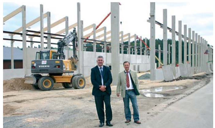
Ziegler mit Projekt-Planer Stephan Lohmeyer (li.) bei der Besichtigung – im Hintergrund entsteht die Sägehalle
